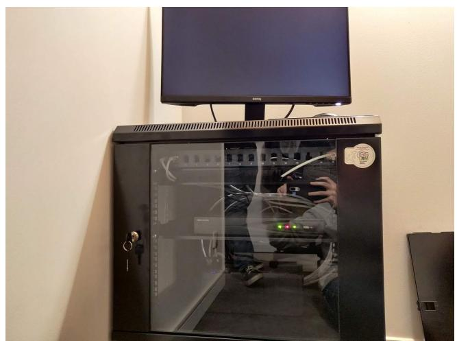
Une fois la baie placée il faut raccorder les câbles prévu pour les caméra à l'enregistreur et connecter ce même enregistreur au réseau.
